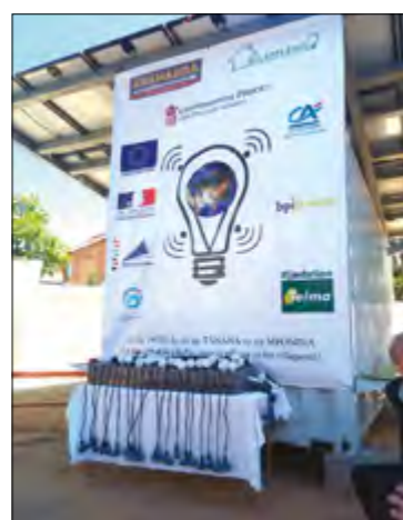
L'unité photovoltaïque et les équipements installés à Akamasoa Antolojanahary
