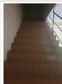
Escalier carrelé vers l'étage
